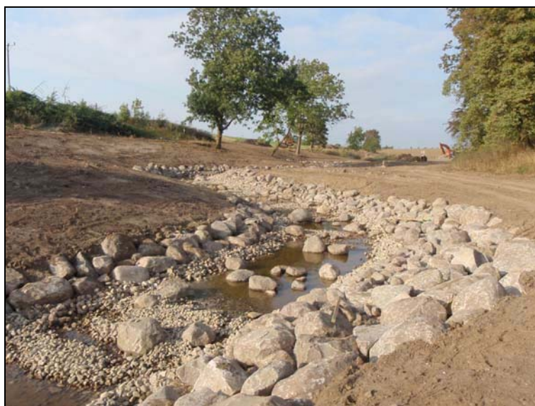
Foto 4.2 Pågående restaurering av Tullstorpsån vid Jordberga med utläggning av sten och block (2009).
